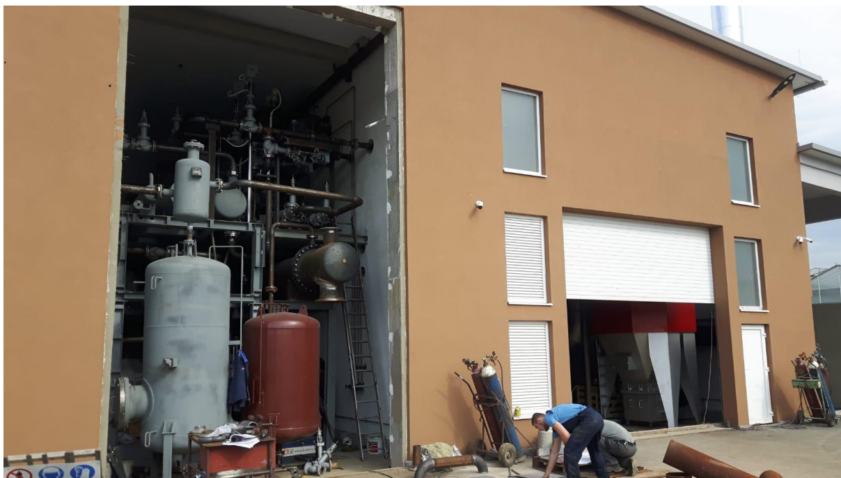
Slika 5: ORC modul i kotlovski dio kogeneracijskog postrojenja
