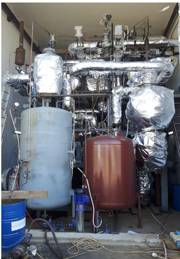
Slika 4: ORC modul kogeneracijskog postrojenja
