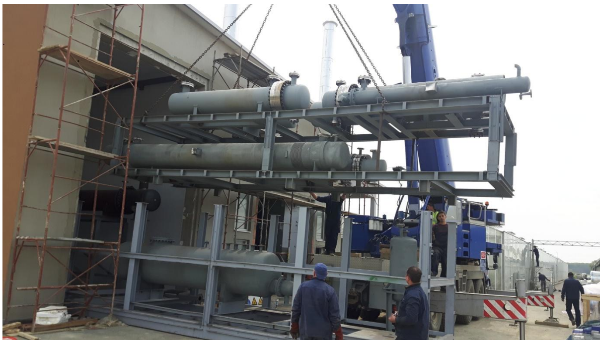
Slika 3: ORC modul kogeneracijskog postrojenja
